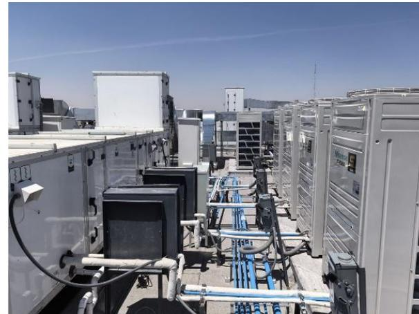
Unidad manejadora de aire de expansión directa con R-410a para exterior, unizona y multizona, doble pared de 50 mm, pre-filtros merv8, filtro intermedio merv11 y filtros terminales merv17, switch de presión y manómetros de presión en secciones de filtros y sección de ventilador, dampers con actuadores modulantes, VFD en motor de ventilador, humidificador y PLC para control de accesorios e instrumentación
